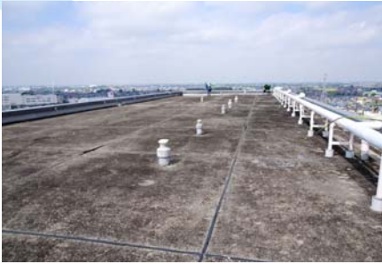
屋上防水改修施工前
