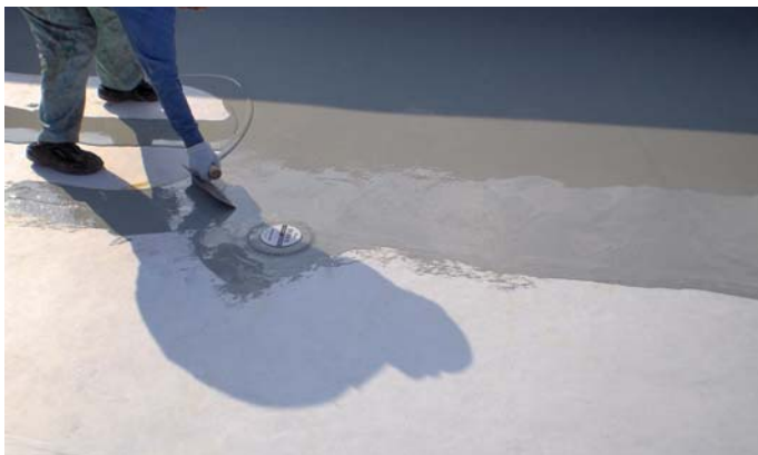
防水材の施工(1層目)
