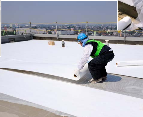
通気緩衝シート(ブルーフロンNT-Fシート#2)の施工
