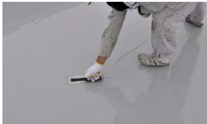
防水材の施工(2層目)
