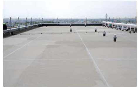
下地処理完了
