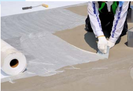
接着剤(ブルーフロンNT-FエコボンドH)の施工
