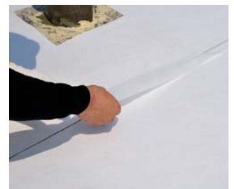
通気緩衝シートのジョイント処理(ブルーフロンNT-Fジョイントテープ)の施工
